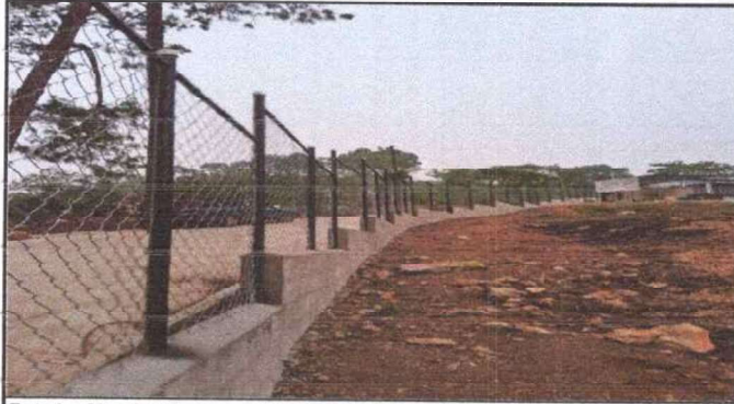
Foto 1: Circulación con malla galvanizada sobre el muro perimetral de 94 metros lineales.
