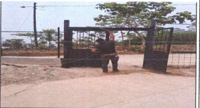
Foto 4: Instalación de porton en la tercera entrada del centro educativo
