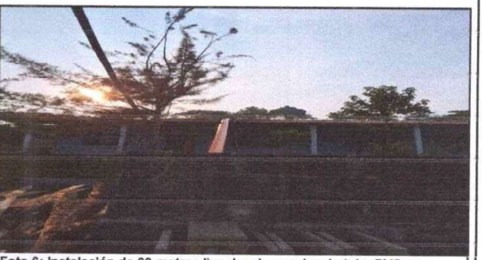
Foto 6: Instalación de 60 metros lineales de canales de tubo PVC que conecta a pila de agua.
