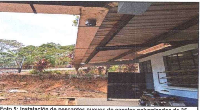
Foto 5: Instalación de pescantes nuevos de canales galvanizados de 35 metros lineales.
